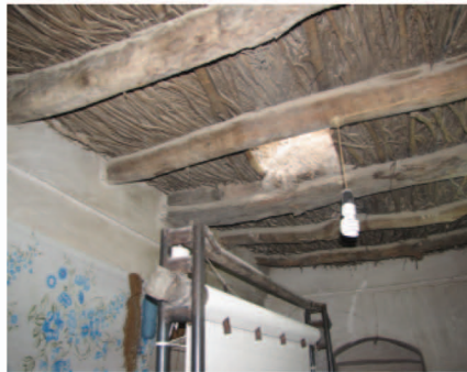
شکل ۱۸- روشنایی مصنوعی در کارگاه
